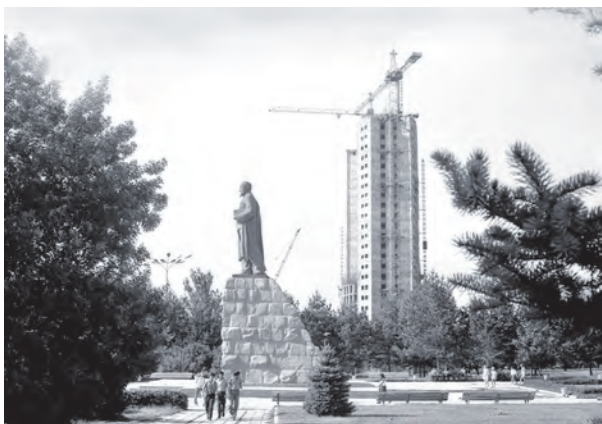
Строительство гостиницы «Казахстан». Алматы. Конец 1970-х гг.
