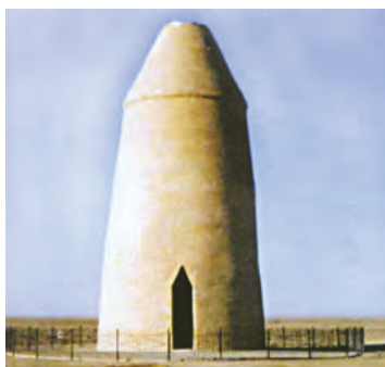
Башня Сараман-Коса. XI в. После завершения реставрационных работ.
